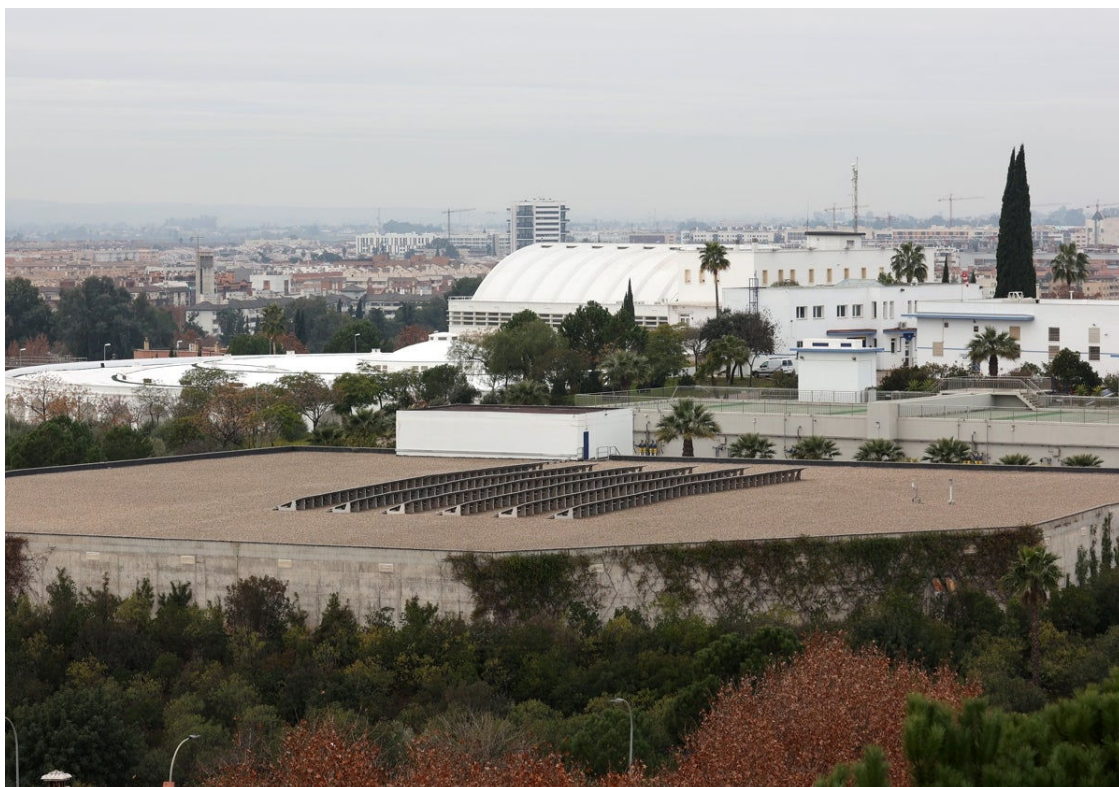
Depósitos e instalaciones de Villa Azul en la zona de El Brillante, una de las dotaciones claves de Emacsa en el abastecimiento de Córdoba Valerio Merino
